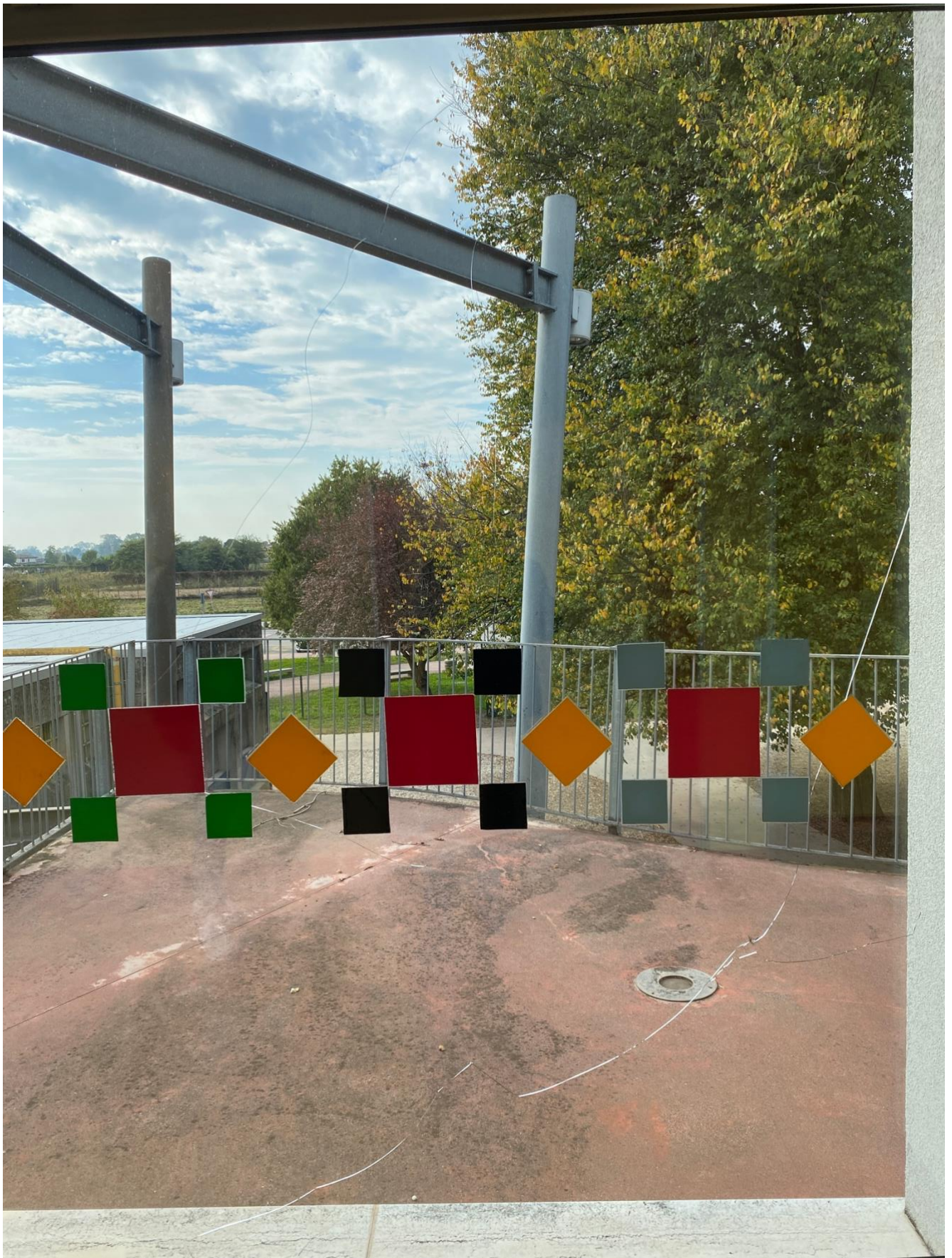
SECONDA VETRATA ROTTA
